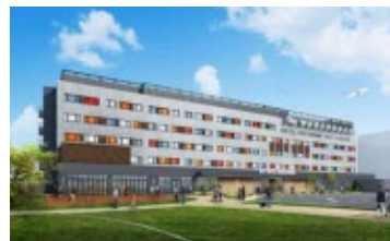
使用済プラスチック由来低炭素水素をエネルギー利用する水素ホテル (川崎キングスカイフロント東急REIホテル)
