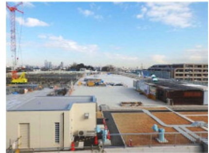
末吉配水池 更新工事
