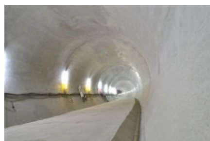
大師河原貯留管の整備
