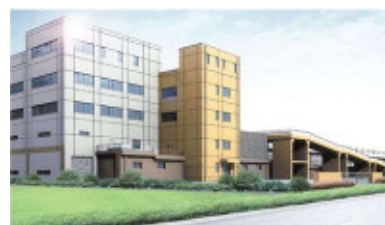
入江崎水処理センター西系再構築
