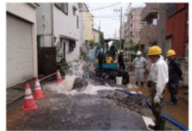
漏水修理工事
