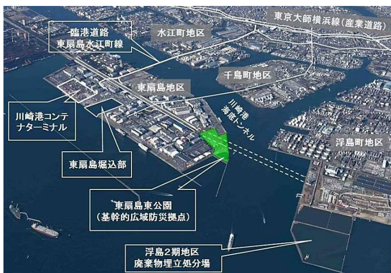
川崎港航空写真
