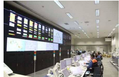
消防指令センター
