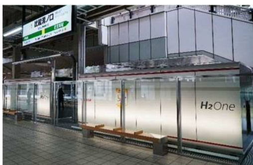
再生可能エネルギーと水素を用いた 自立型エネルギー供給システムの導入事例 (JR南武線武蔵溝ノ口駅)
