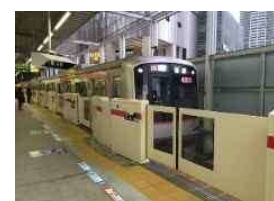
東急東横線武蔵小杉駅のホームドア
