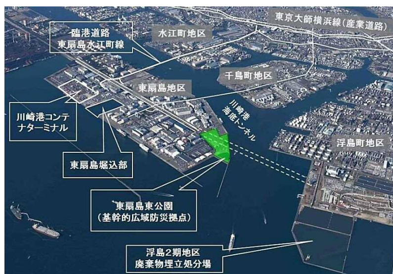
川崎港航空写真
