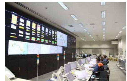
消防指令センター
