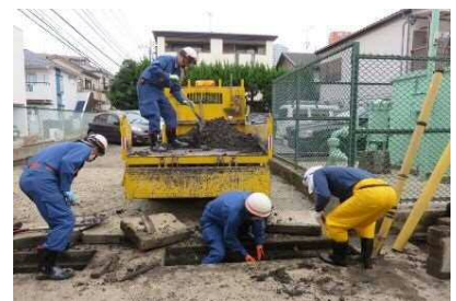
令和元年台風第19号での消防団員の活動
