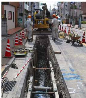
耐震管布設工事
