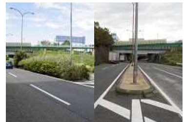
中央分離帯の植樹を 土系舗装に改良
