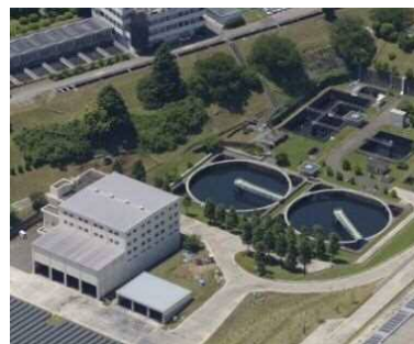
長沢浄水場排水処理施設
