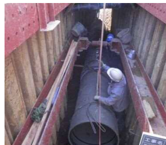
雨水管布設工事
