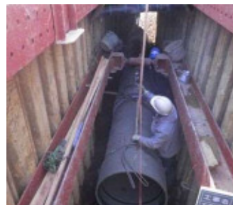
雨水管布設工事
