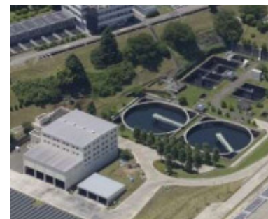
長沢浄水場排水処理施設
