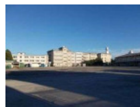
再生整備実施：渡田中学校
