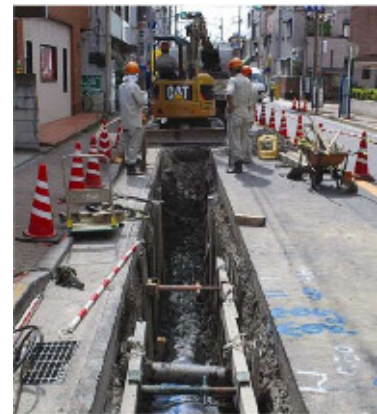
耐震管布設工事
