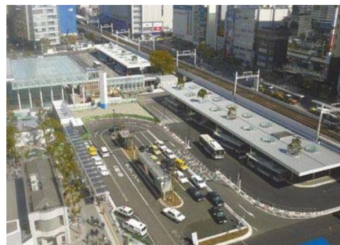
川崎駅東口駅前広場
