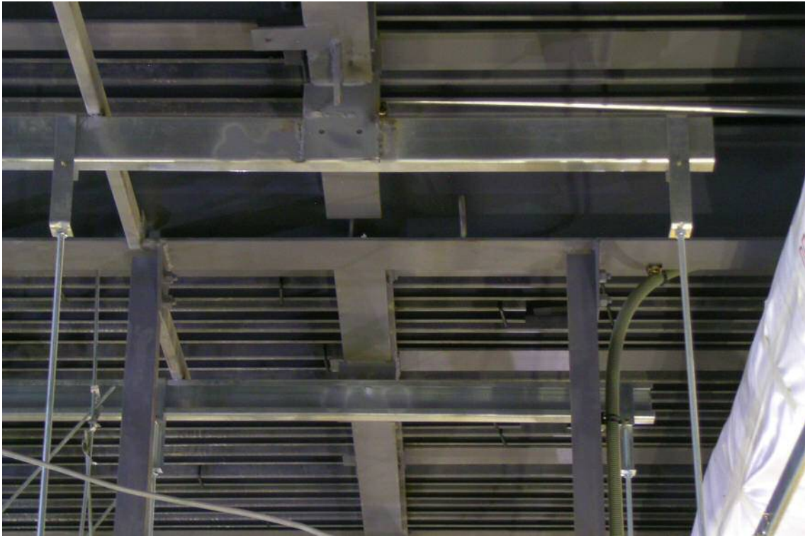
写真 5.3.14 片持 1次下地材—吸音幕の際 (撮影 2011.12.9)
