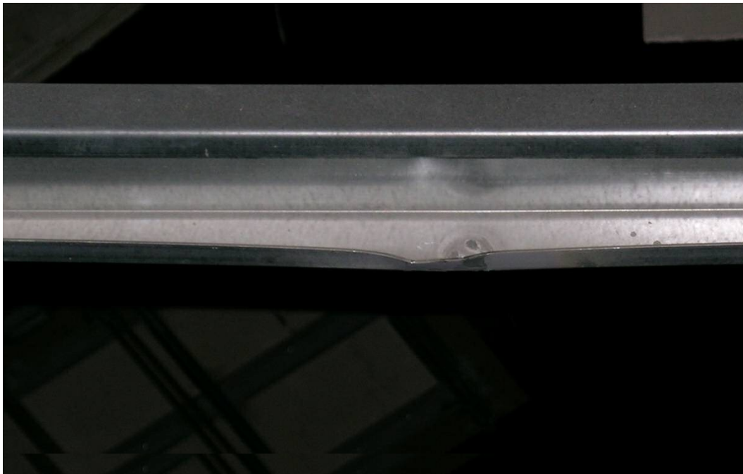
金具の残存：なし，滑り跡長さ：約 2cm，リップ変形位置：約 2cm，リップ変形：小（2～6mm），下フランジ：顕著な開き，溶接状況：ボルト頭，調査エリア：i 上手
