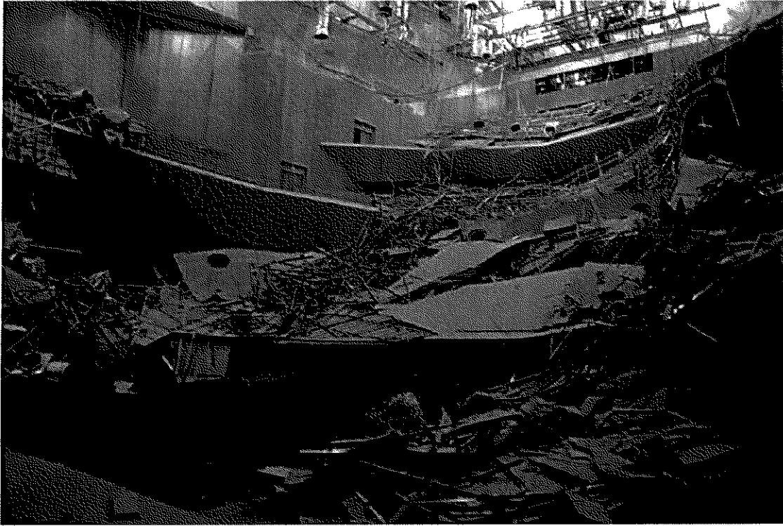
写真1 ホール内部の天井落下状況（舞台下手側入口付近より 撮影 2011.3.23）
