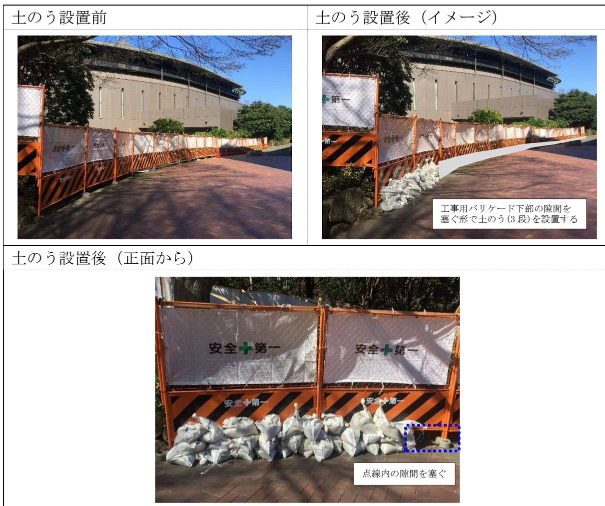
図 13：工事中バリケードを利用した土のうの設置イメージ
