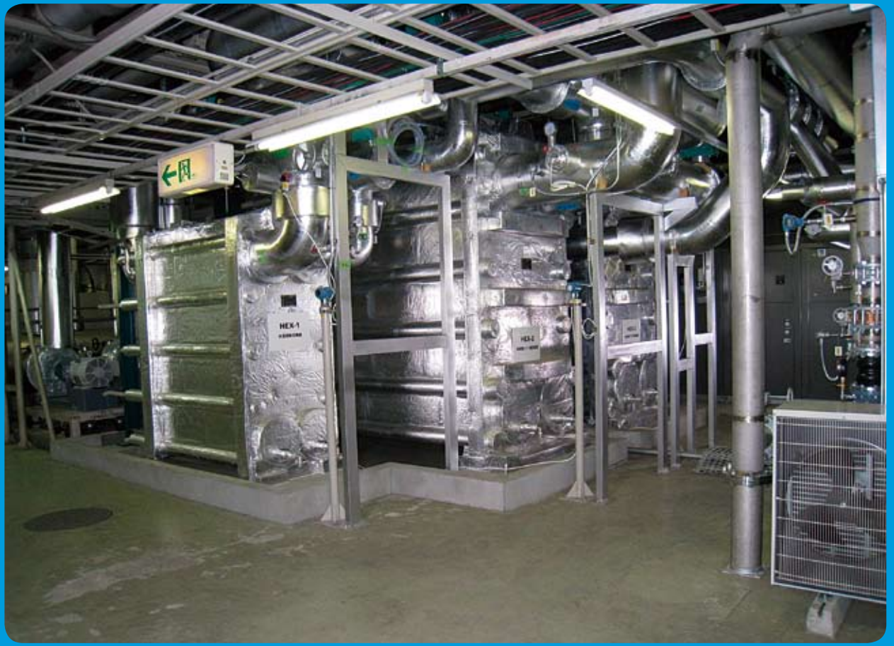
川崎アゼリア地下に設置されている水和物スラリ製造装置
