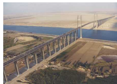
スエズ運河橋
