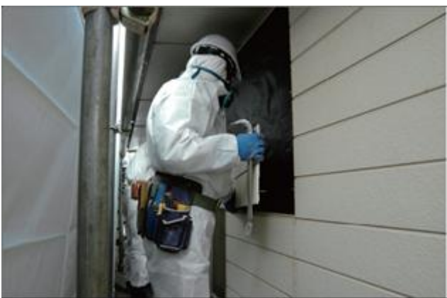
除去した成形板は手渡しで降ろす
