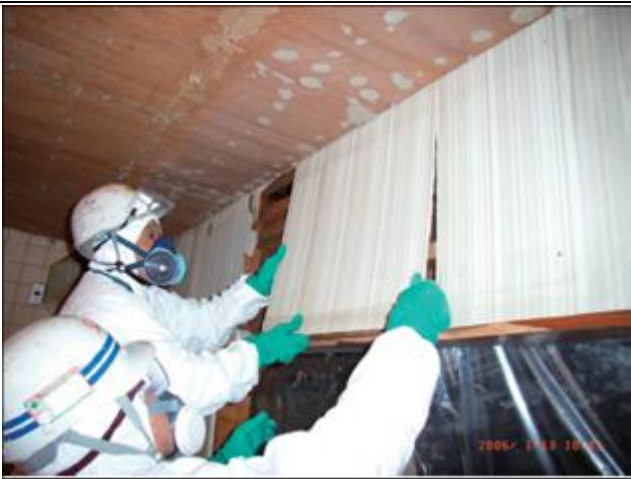
除去した成形板は手渡しで降ろす
