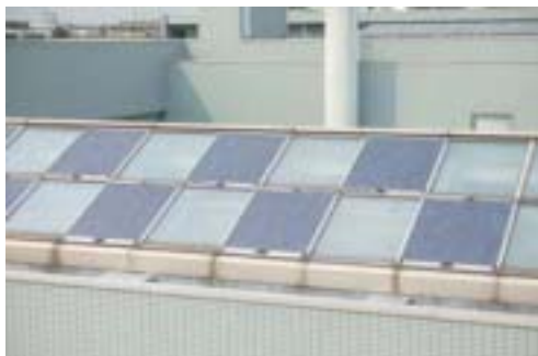
プロムナード上部に設置した太陽光パネル
