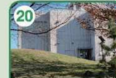
20 大師河原水防センター
