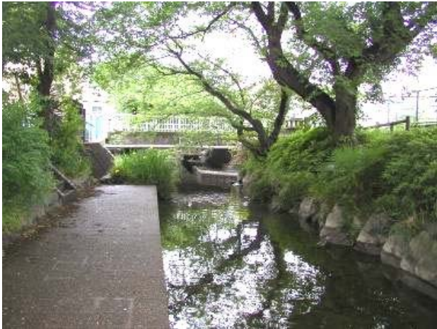
二ヶ領用水宿河原線・親水施設 —北村橋の上流付近(多摩区宿河原)— 市街地内の水辺の散策ができる貴重な オープンスペース。
