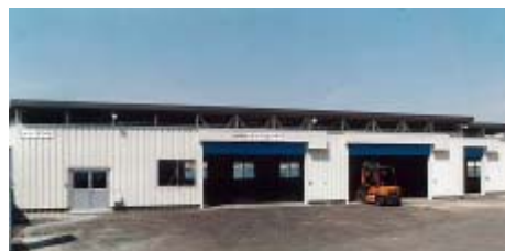
↑ リサイクルセンター（場内集積場）
