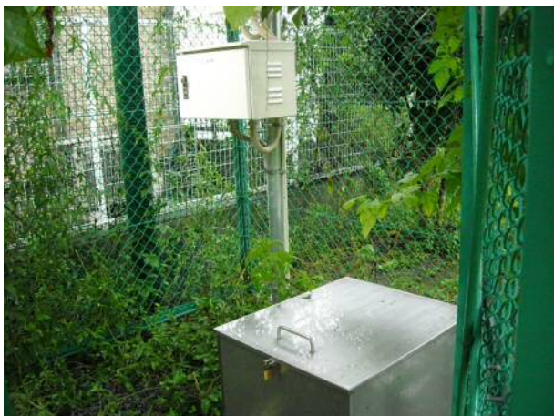
地盤沈下観測所の水位計と沈下計
