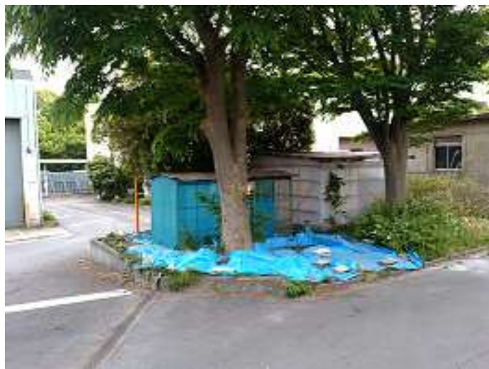
ブルーシートによる養生
