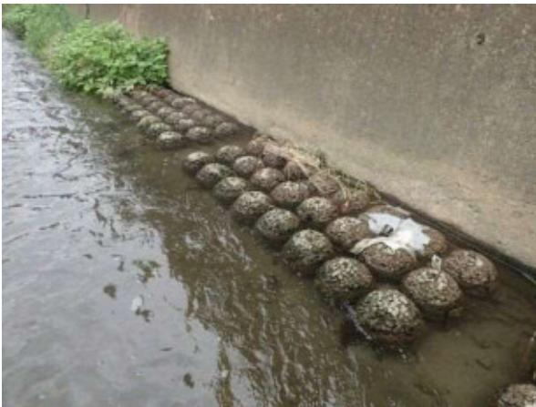
緑化工（三沢川・下の橋）
