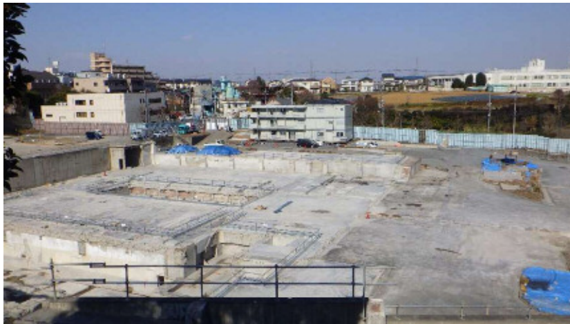
② ごみ焼却処理施設2
