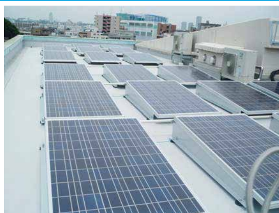
太陽光パネル
