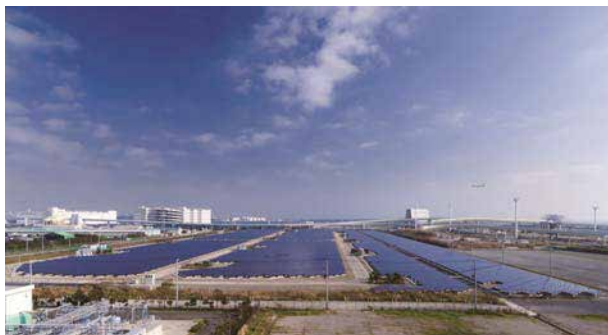
浮島太陽光発電所
