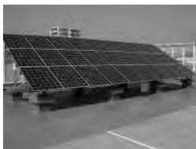
太陽光発電設備 (麻生区役所)
