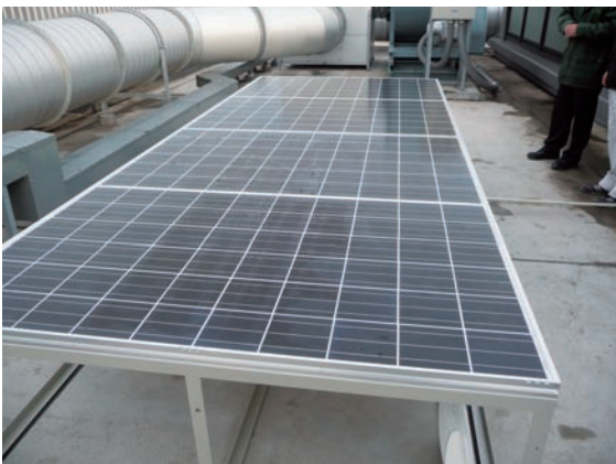
共同研究により実証実験を行った 直流給電方式の太陽光発電システム
