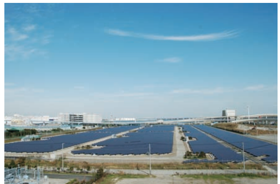
隣接する浮島太陽光発電所
