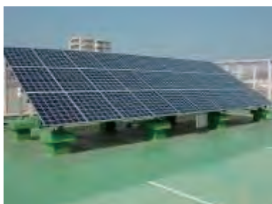
太陽光発電設備 (麻生区役所)
