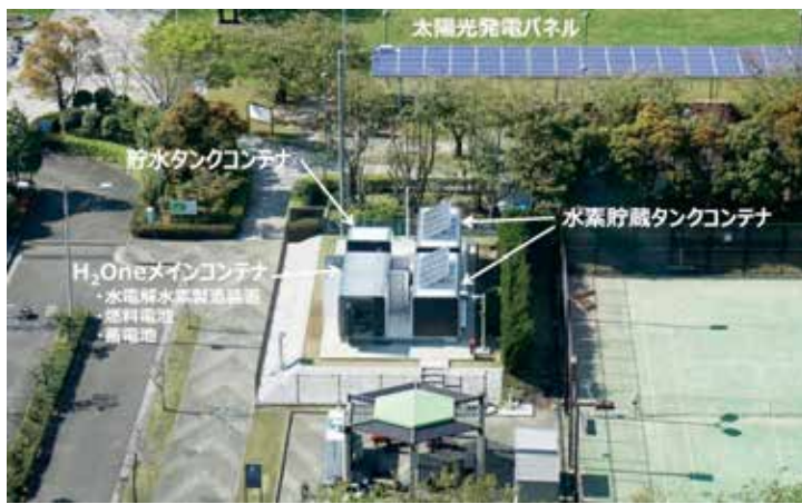
再生可能エネルギーと水素を用いた 自立型エネルギー供給システム 「H2One」(川崎マリエン)
