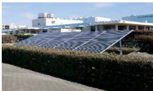
太陽光発電設備（川崎マリエン）
