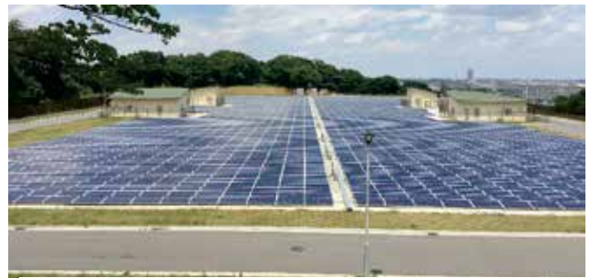
生田配水池に導入した太陽光発電設備
