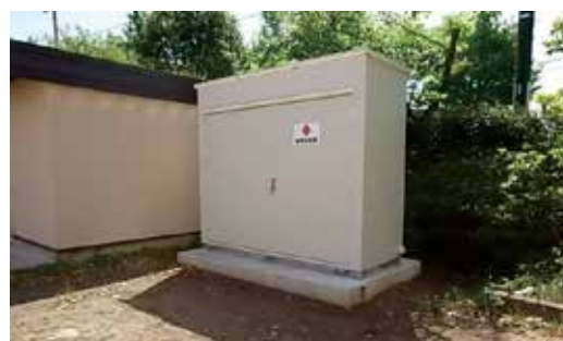
蓄電池（王禅寺中央中学校）
