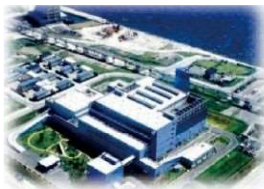
浮島処理センター
