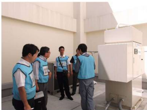
防災用自家発電装置
