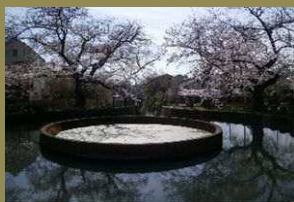
二ヶ領用水久地円筒分水
