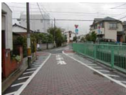
道幅が狭く見えるように工夫されたカラー舗装（イメージパンプ）
