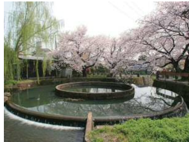
②久地円筒分水
