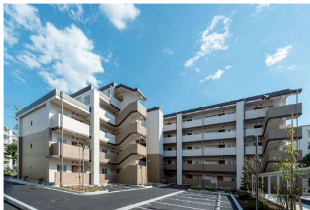
建替えを行った市営住宅
