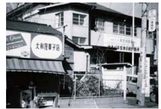
4. 大和屋菓子店と旧高津支所
