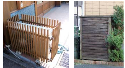
設備を修景した事例
