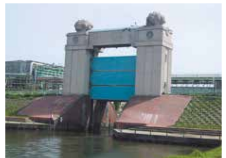
川崎河港水門
