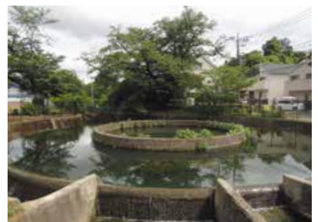
二ヶ領用水久地円筒分水
