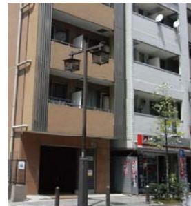
外壁面がすっきり整ったインナーバルコニー型の建物
