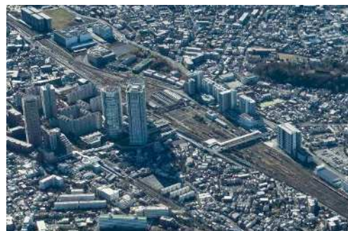
現在の新川崎駅周辺の様子
