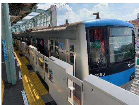
小田急小田原線登戸駅上り線ホームドア （令和3年度整備完了）
