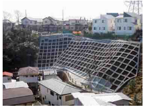
図 急傾斜地崩壊対策工事の事例
