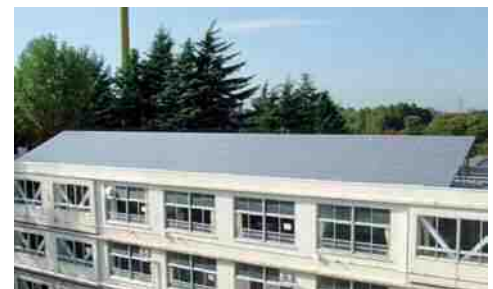
図 太陽光発電設備設置(西丸子小学校)
