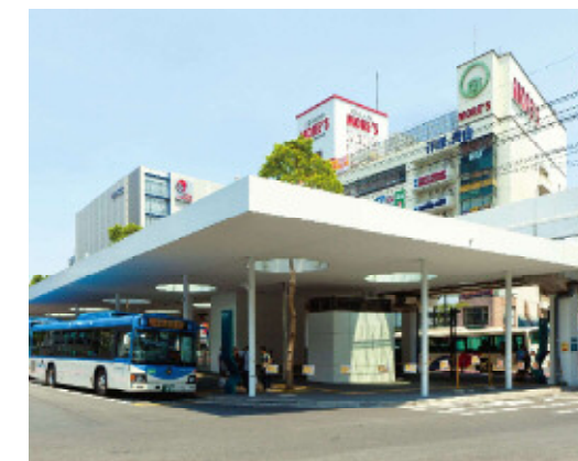
バス島を集約するとともに、階段の上屋を撤去し、フラットな屋根を高い位置に架けることで、視認性と開放性を確保
