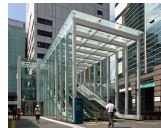
東西連絡歩道橋の段差をスロープにより解消し、エレベーター・エスカレーターを新設
