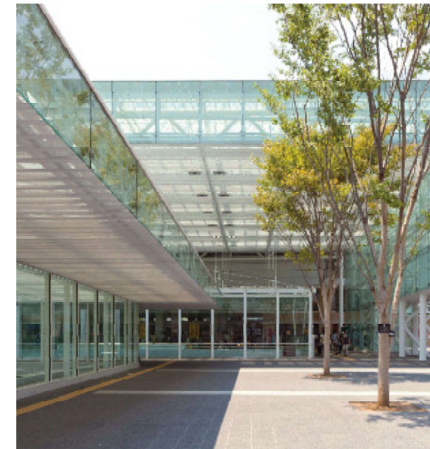
L字型の大屋根と、その下に入れ子となっている地下街の空調の風除けとなるガラスの中屋根
