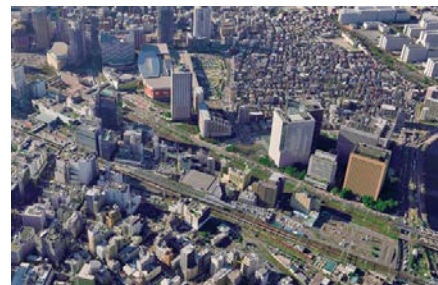
京急川崎駅周辺地区
