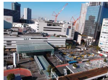
川崎駅東口駅前広場
