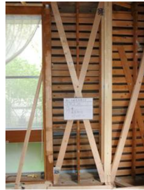
木造住宅の耐震補強イメージ
