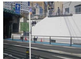
壁面の落書き除去の例
