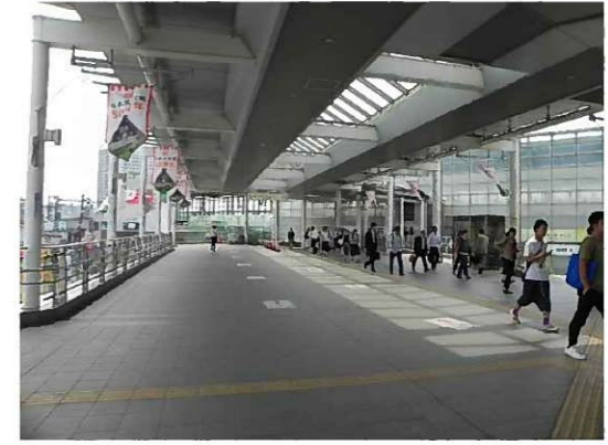
踏切による迂回をせずに安全に鉄道を横断できる歩行者施設
