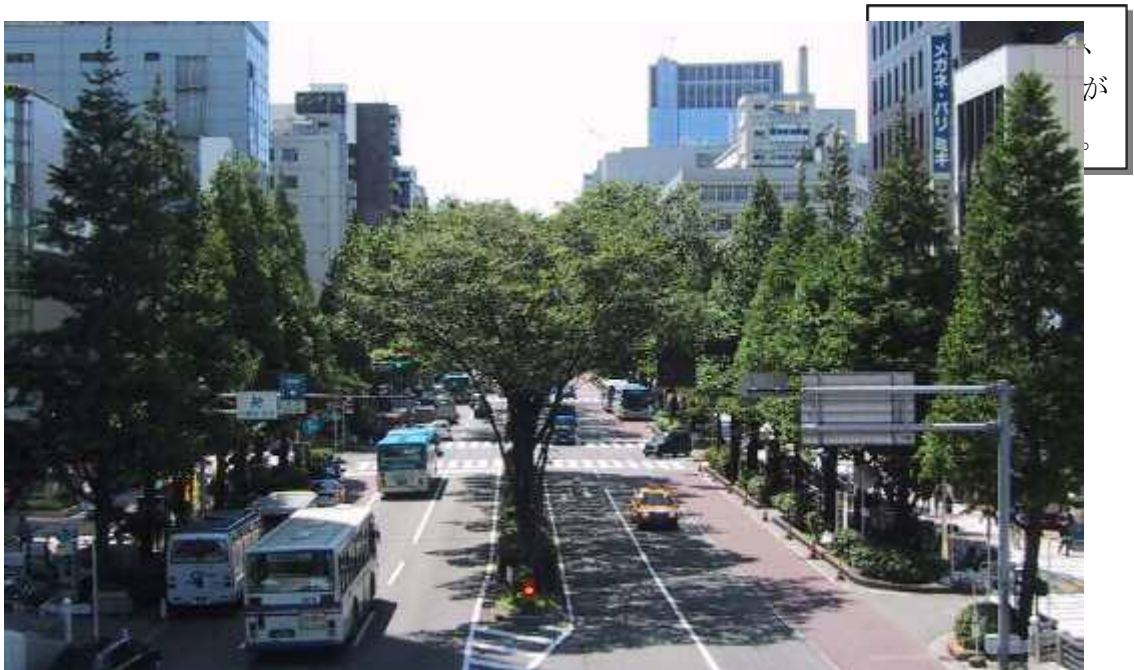
図 4-12 都市計画道路 川崎駅東扇島線
