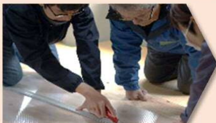
断熱材カット
