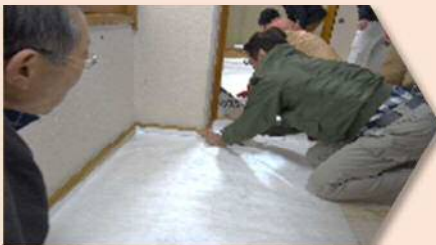
断熱ボード 敷設
