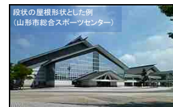
段状の屋根形状とした例（山形市総合スポーツセンター）
