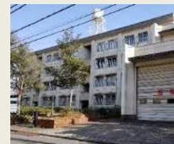
〈消防小田公舎〉
