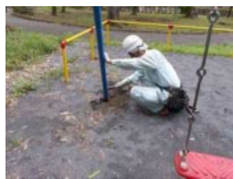
遊具の安全点検
