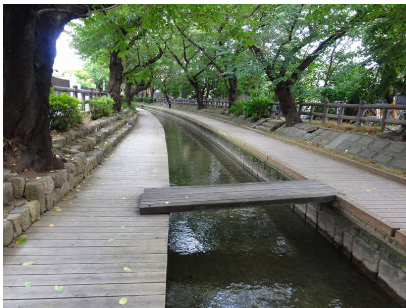
図 33 遊歩道の整備
