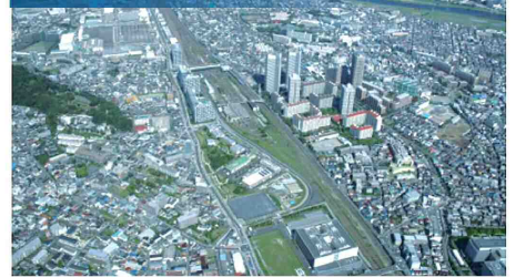
新川崎駅・鹿島田駅周辺
